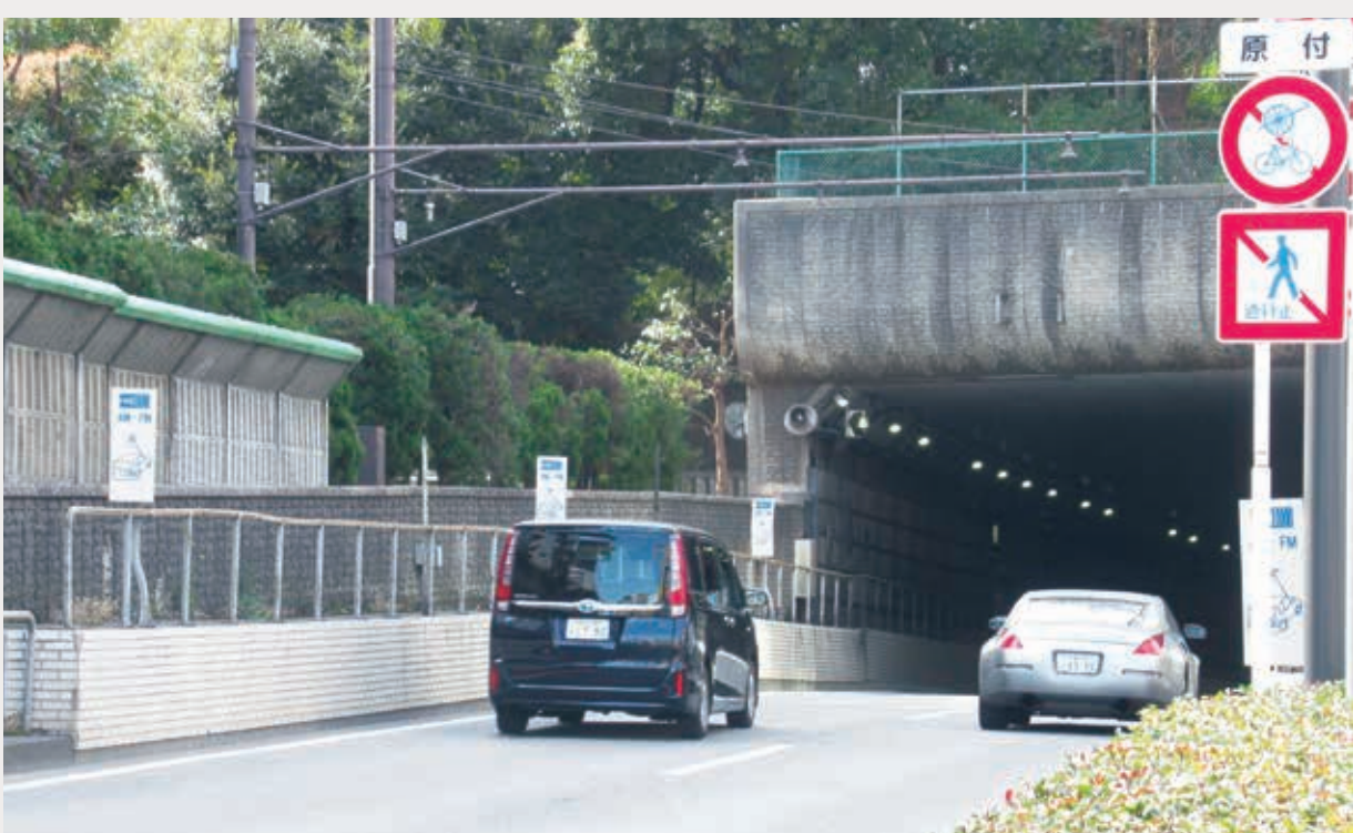
新宿御苑トンネル
