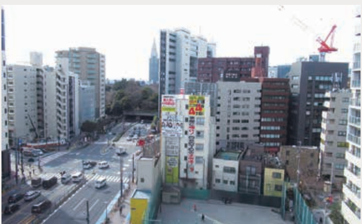
新宿区四谷区民センター（中央の白いビル）
